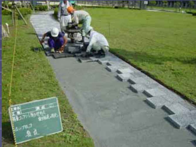
( ブロック敷設状況 )
