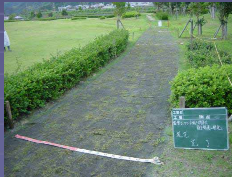
試験舗道完成 2004/9/22
