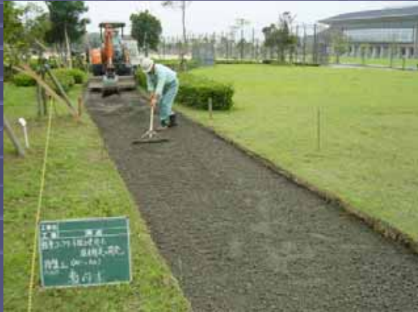
(路盤工 碎石敷均)
