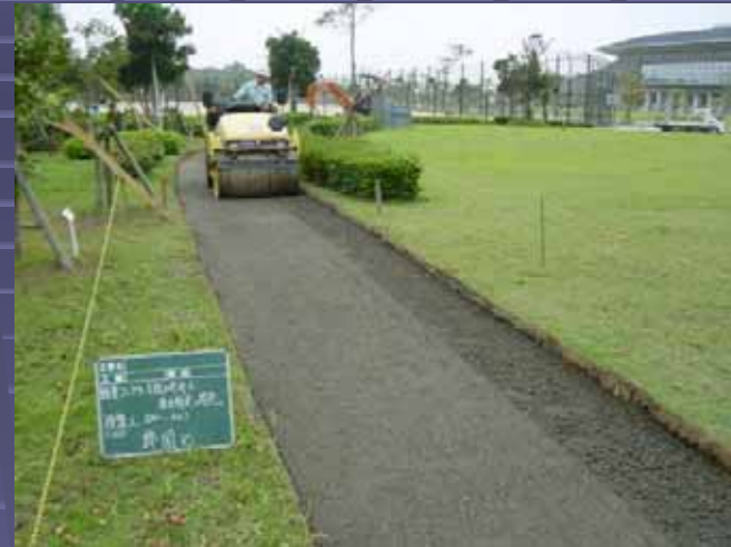
(路盤工 転圧状況)
