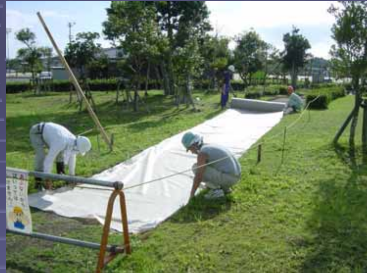
( 透水マット敷設状況 )
