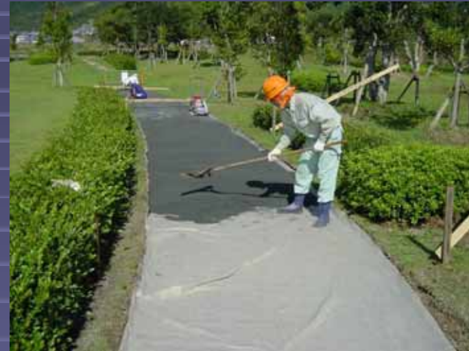
(クッション砂施工状況)
